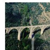
42-EL VIADUCTO DE GUADALUPE
