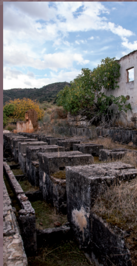
Instalaciones mineras abandonadas
